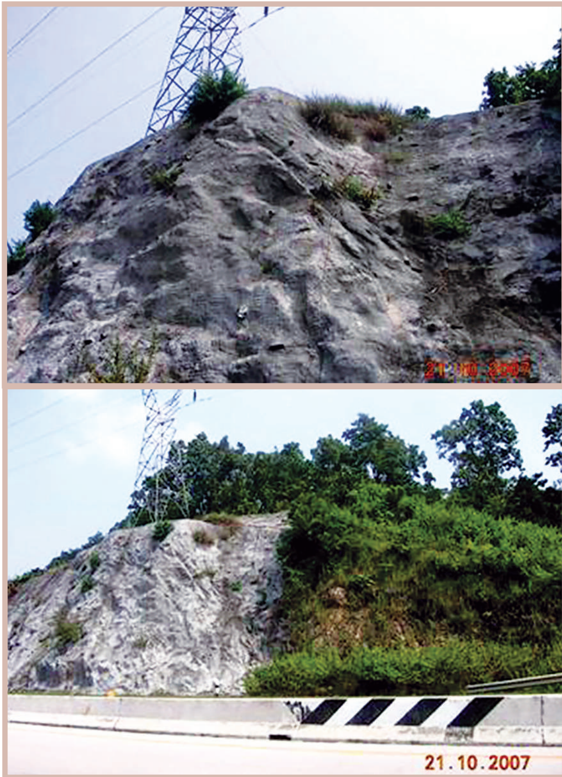
รูปที่ 2-16 ตัวอย่างการป้องกันลาดด้วยคอนกรีตพ่น (shotcrete) ที่มา : อัครพัฒน์ สว่างสุริย์ เอกสารประกอบการบรรยาย 30
