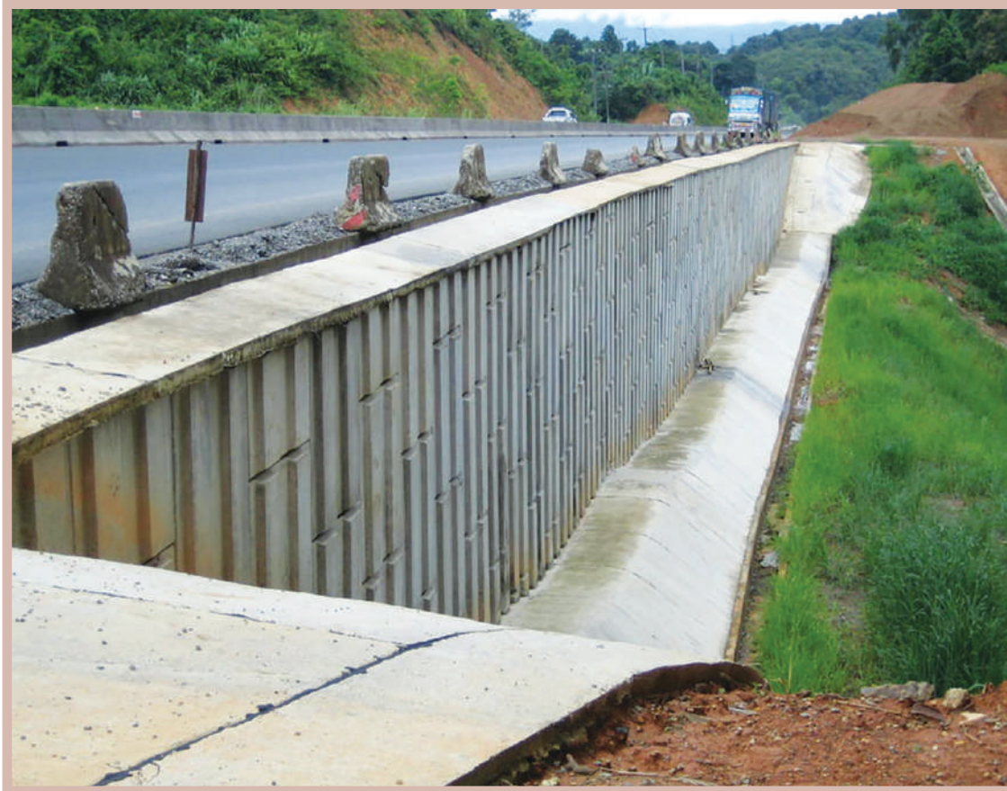
รูปที่ 3-16 งานก่อสร้างกำแพงกันดินเสริมแรง (MSE wall) ที่มา : สำนักงานก่อสร้างทางที่ 1 67
