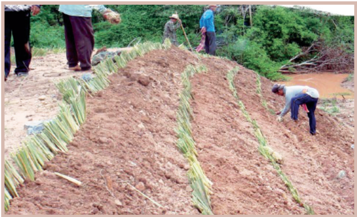
รูปที่ 3-5 ตัวอย่างการวางแนวและเตรียมร่องปลูกหญ้าแฝก
