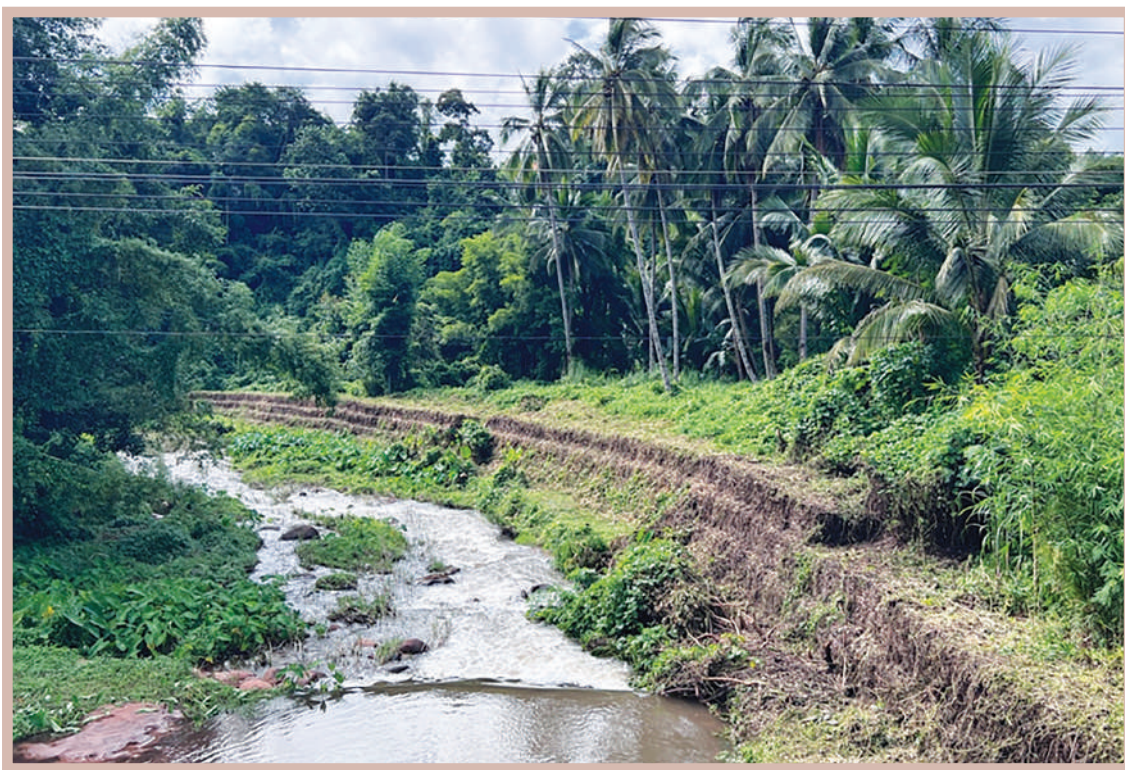
รูปที่ 3-10 การป้องกันเสถียรภาพเชิงลาดตลิ่งน้ำด้วยกอ่งหินเกเปี้ยน ที่มา : ถ่ายโดยคณะผู้จัดทำ วันที่ 25 กันยายน 2568 อำเภอน้ำปาด จังหวัดอุตรดิตถ์
