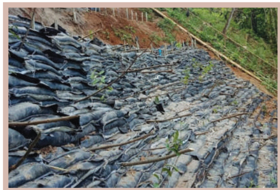
รูปที่ 3-11 การใช้กระสอบแบบมีปีกร่วมกับพืชท้องถิ่นและเสาเข็มสกรูเพื่อเสริมเสถียรภาพลาดดิน ที่มา : Jotisankasa et al. (2025) 60 บริเวณทางหลวงชนบทสาย กจ.4088 กม.16+700 อำเภอทองผาภูมิ จังหวัดกาญจนบุรี
