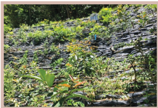
รูปที่ 3-11 การใช้กระสอบแบบมีปีกร่วมกับพืชท้องถิ่นและเสาเข็มสกรูเพื่อเสริมเสถียรภาพลาดดิน ที่มา : Jotisankasa et al. (2025) 60 บริเวณทางหลวงชนบทสาย กจ.4088 กม.16+700 อำเภอทองผาภูมิ จังหวัดกาญจนบุรี
