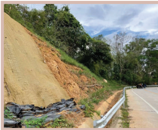
รูปที่ 3-13 การเสริมเสถียรภาพลาดถนนด้านหลังผาโดยใช้กระสอบแบบมีปีก เสาค้ำเสริมสกรูและตะปูดิน บริเวณบ้านปากเหมือง ถนน กจ.3091 อำเภอทองผาภูมิ จังหวัดกาญจนบุรี ที่มา : ประกิต ไชยศรี และคณะ (2565) 62
