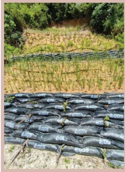
รูปที่ 3-12 ตัวอย่างการใช้กระสอบแบบมีปีกร่วมกับมาตรการชีววิศวกรรมเพื่อป้องกันการกัดเซาะและเสริมเสถียรภาพลาดดิน ทล. 4029 ตอนกะทู้ - ปาดอง กม.0+125 จังหวัดภูเก็ต ที่มา : อภินิติ (2569) เอกสารการบรรยายการ โครงการฝึกอบรม “ครูหญ้าแฝก” รุ่นที่ 3 61
