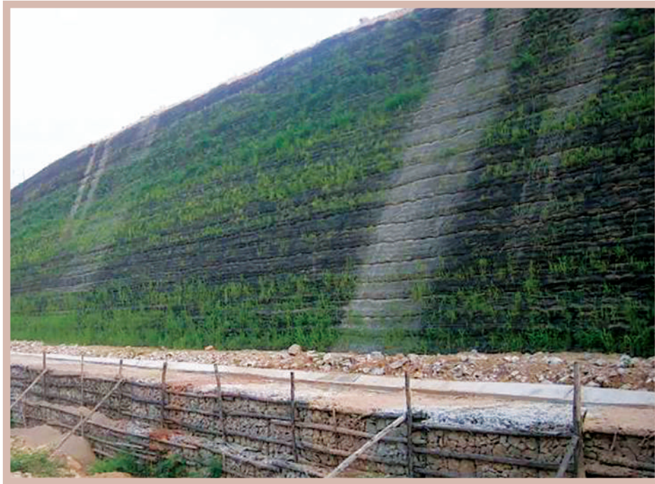
รูปที่ 2-23 ตัวอย่างการปลูกพืชบนผิวลาดด้วยถุงดิน (soil bag) ที่มา : อัครพัฒน์ สว่างสุริย์ เอกสารประกอบการบรรยาย 37
