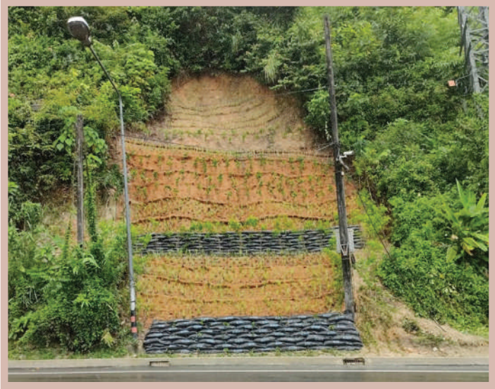
รูปที่ 3-12 ตัวอย่างการใช้กระสอบแบบมีปีกร่วมกับมาตรการชีววิศวกรรมเพื่อป้องกันการกัดเซาะและเสริมเสถียรภาพลาดดิน ทล. 4029 ตอนกะทู้ - ปาดอง กม.0+125 จังหวัดภูเก็ต ที่มา : อภินิติ (2569) เอกสารการบรรยายการ โครงการฝึกอบรม “ครูหญ้าแฝก” รุ่นที่ 3 61
