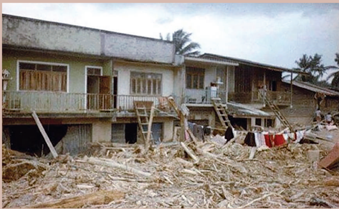
รูปที่ 1-3 ความเสียหายจากโคลนถล่ม บ้านกะทูน อำเภอฟิปูน จังหวัดนครศรีธรรมราช 1,2
