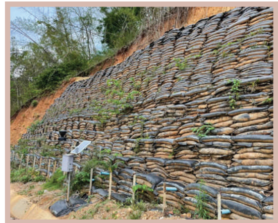
รูปที่ 3-13 การเสริมเสถียรภาพลาดถนนด้านหลังผาโดยใช้กระสอบแบบมีปีก เสาค้ำเสริมสกรูและตะปูดิน บริเวณบ้านปากเหมือง ถนน กจ.3091 อำเภอทองผาภูมิ จังหวัดกาญจนบุรี ที่มา : ประกิต ไชยศรี และคณะ (2565) 62
