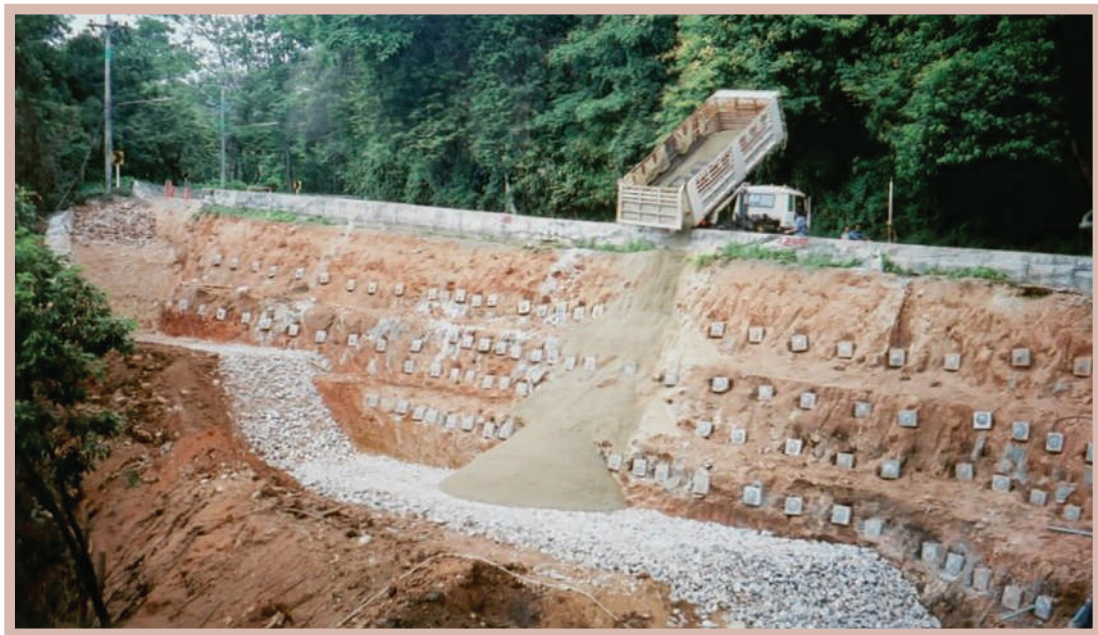
รูปที่ 2-15 ตัวอย่างการใช้ตะปูดินเสริมเสถียรภาพของคันทาง ที่มา : อัครพัฒน์ สว่างสุริย์ เอกสารประกอบการบรรยาย 29
