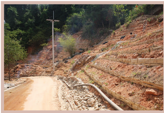
รูปที่ 4-25 การปรับปรุงพื้นที่โครงการฯ บ้านหน้าถ้ำ ในปี พ.ศ. 2558 ที่มา : โครงการประยุกต์ใช้หญ้าแฝกร่วมกับวิธีกลและพืชอื่นเพื่อป้องกันภัยดินถล่ม (ปทท.)
